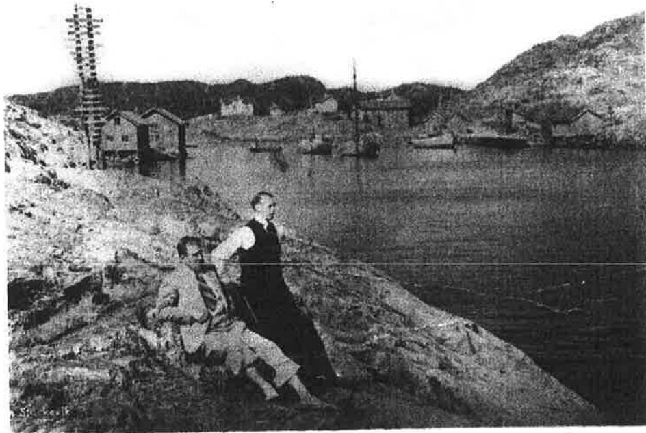
Nordsidans sjöbodar. Observera också sjömärket för telekabeln till Klädesholmen. Motsvarande märke stod ute på "Holmen". När de var ens, var det förbjudet att ankra. Kabeln togs bort i samband med att bron till Klädesholmen byggdes. Förgrundens "badgäster" är Källberg på Önne, som var klockare och organist i Stenkyrka samt Viktor Strandberg från Stockevik*. * se hus nr 27
